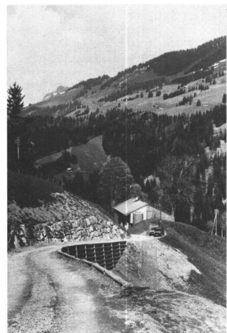
Abb. 1: Landschaftsschutz beim Wegebau: Grösste Beschränkungen bei den Kunstbauten durch optimale Anpassung der Weglinie ans Gelände. Armco-Kassettenstützwände (siehe Bild) oder Betonmauern nur wo absolut unumgänglich anwenden. Blocksteinmauern wie hier bergseitig wirken wenig störend. Weg Linter in der Gemeinde Frutigen/BE. Es folgt noch ein Oberflächenabschluss in Form einer 6 cm starken HMT (Foto 22.5.1984, KMA Bern).
