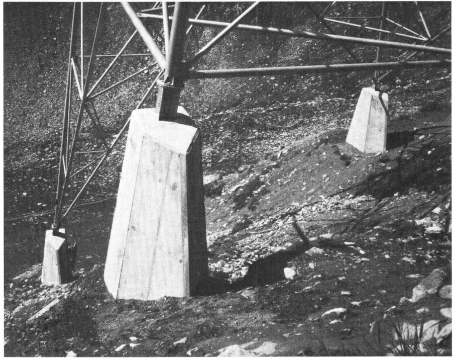
**Abb. 15: 400-kV-Mast, Lukmanierleitung, Fundamente mit Lawinenkeil**
