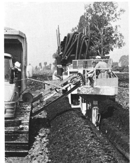
Abb. 4 Draingrabenfräsmaschine im Einsatz
