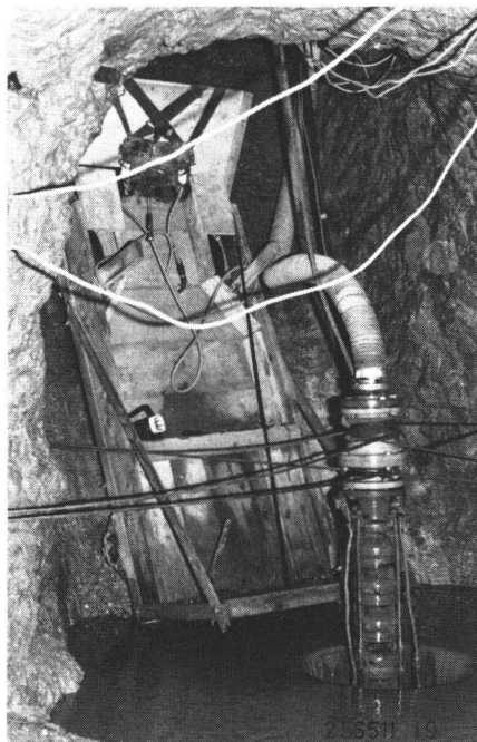
Fig. 1 Le wagonnet du funiculaire et la pompe pour l'évacuation de l'eau au bas de la galerie inclinée.
