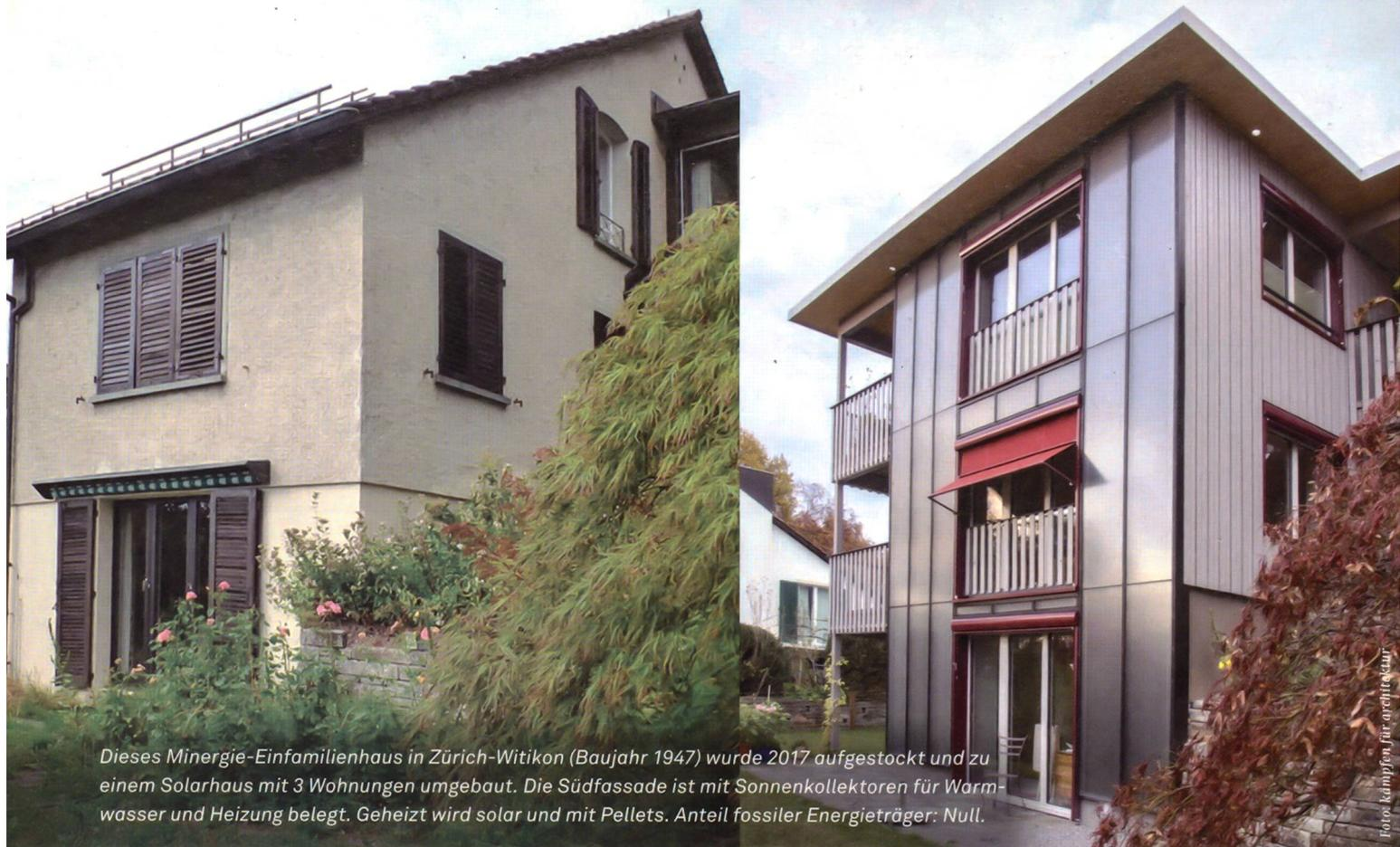
Dieses Minergie-Einfamilienhaus in Zürich-Witikon (Baujahr 1947) wurde 2017 aufgestockt und zu einem Solarhaus mit 3 Wohnungen umgebaut. Die Südfassade ist mit Sonnenkollektoren für Warmwasser und Heizung belegt. Geheizt wird solar und mit Pellets. Anteil fossiler Energieträger: Null.
