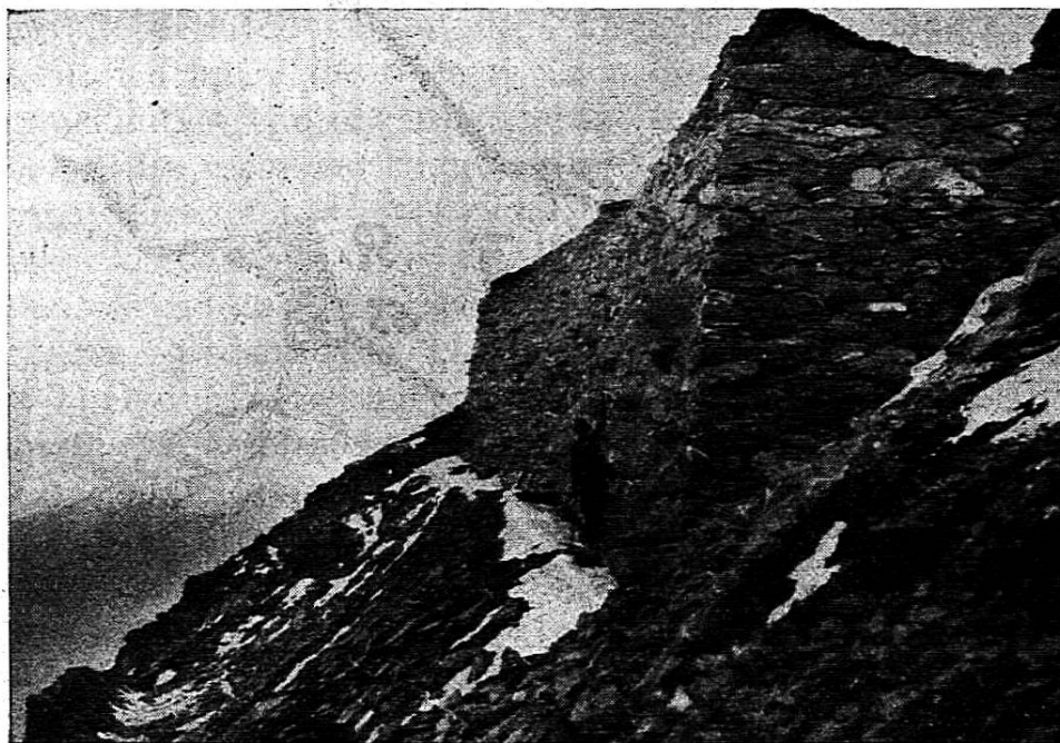
Mur de protection à Faldum.
