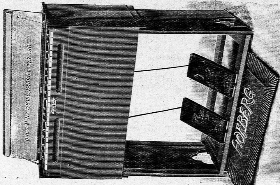
Plié et fermé, cet Harmonium représente une malle portée au moyen d'une poignée en cuir placée derrière l'instrument. Poids 13 kg.
