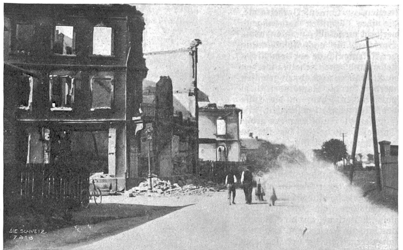
Die Hauptstraße des fast weise zerstörten Burzweiler bei Mülhausen. Phot. Willy Schneider, Zürich.
