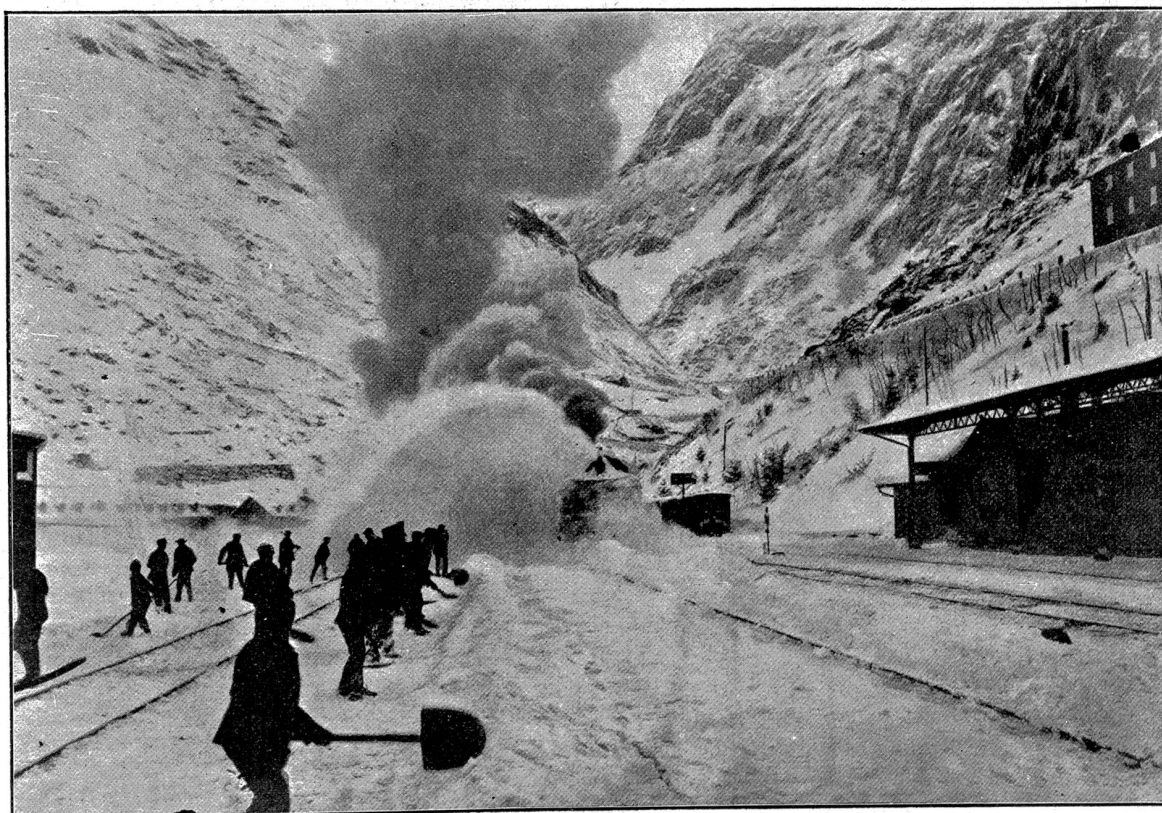
Die Schneeschleudermaschine der Gotthardbahn. Vergl. Text S. 161.
