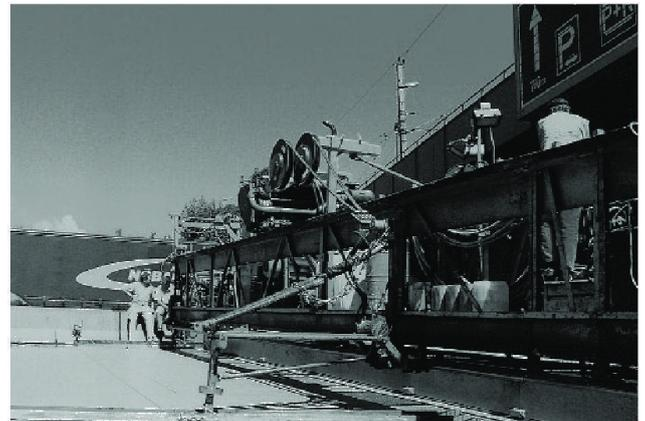
**Abb. 5** Mit dem Längsglätter am zweiten Gleitschalungsfertiger wird die Ebenheit des Oberbetons optimiert.
