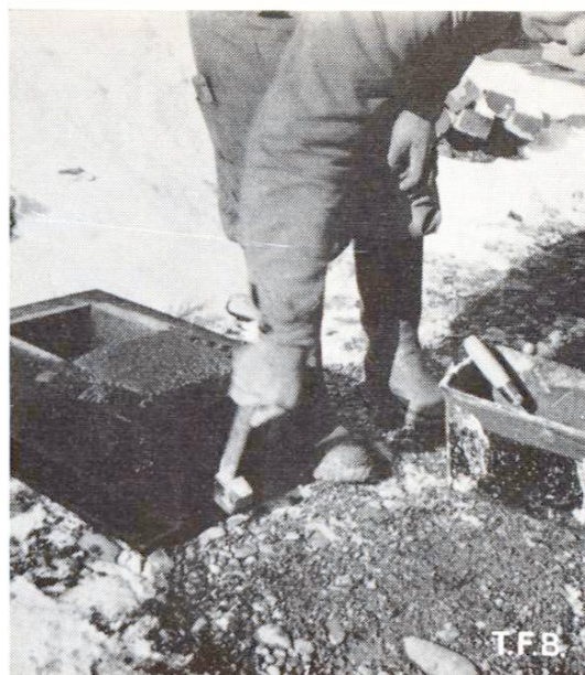
Abb. 6 Zusätzliche Verdichtung durch leichtes Abklopfen der Form
