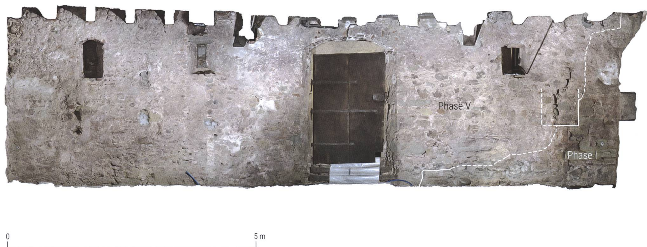
Abb. 6 Orthophoto der Ostmauer mit Phasengrenze und mutmasslichen Resten eines Türgewändes mit Schwelle
