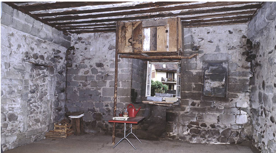
Abb. 8 Moudon, Rue du Château 5: mittelalterliche Konsolen im oberen Kellergeschoss
