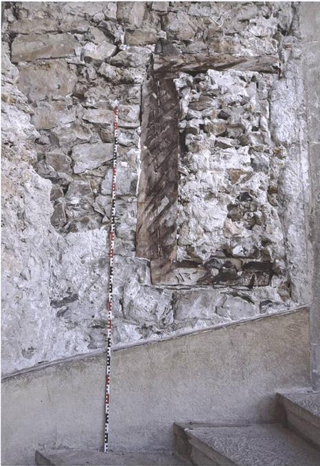
**Fig. 8** Fenêtre remontant à la première phase de transformation du bâtiment
