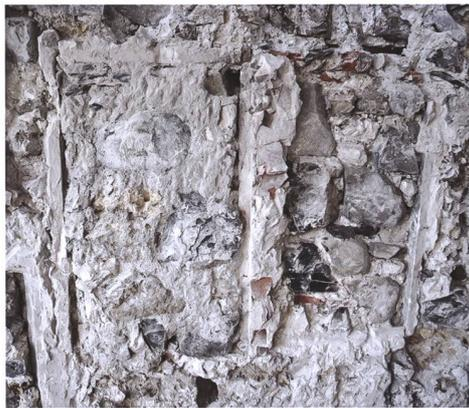
**Fig. 10** Fenêtres successives à encadrement rectangulaire simple
