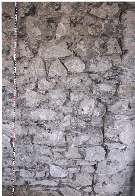
**Fig. 6** Extrémité nord-est de la maison primitive, visible grâce à la différence des modules en façade
