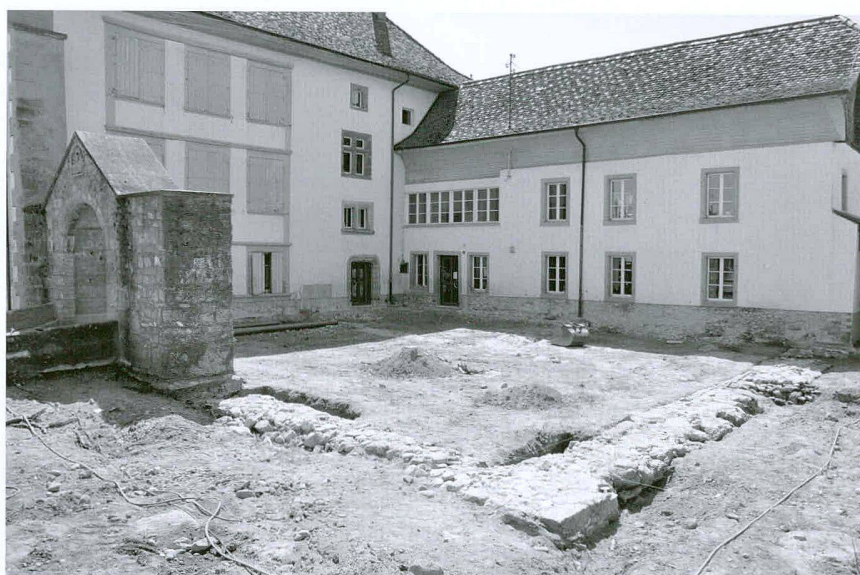
Fig. 5 Cugy/Château. Vue de l'enceinte après dégagement
