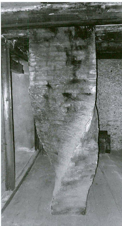
Abb. 14 Murten/Hauptgasse 6. Kamin im dritten Obergeschoss
