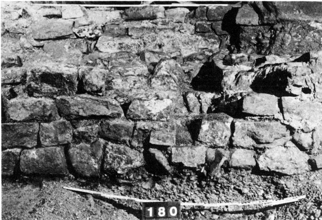
Abb. 45. Schneidergasse 2, 1982/3. Phase 1: Böschungsmauer aus weitgehend trocken versetzten Quadern (Abb. 44, A). Im Hintergrund ist die jüngere Stützmauer sichtbar. Blick gegen Westen. (Abb. 44, G).
