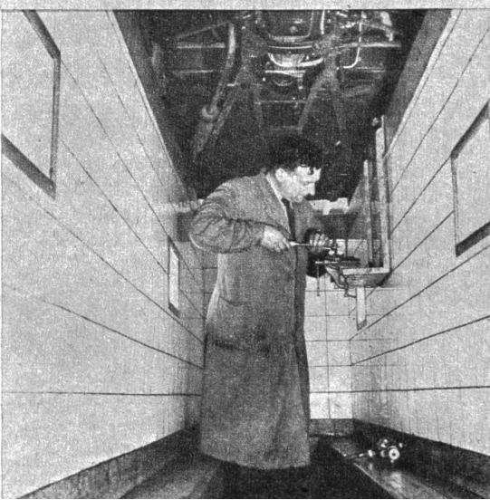
Detailansicht einer der Servicezellen der grossen Anlage von unten
