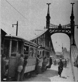
Eine der zwei sich jetzt in Betrieb befindlichen Brücken zwischen Buda und Pest, die Freiheitsbrücke (früher Franz-Josefs-Brücke)
