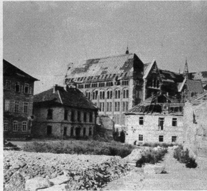
Was von der Burg übrig geblieben ist: Nichts als Ruinen und verbrannte Fassaden. Unersetzliche Kunst- und Kulturwerte gingen auf immer verloren
