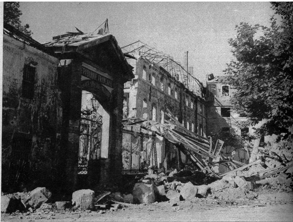
In der Militärakademie von St. Cyr war während des Krieges ein wichtiges deutsches Verbindungsquartier eingerichtet. Das war den Alliierten wohlbekannt, weshalb die Gebäulichkeiten mehrmals schwer bombardiert wurden. Die Schäden sind derart schwer, dass verschiedene Trakte neuaufgebaut werden müssen
