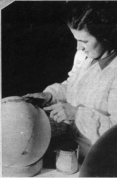
Die Unebenheiten in der Rohkugel werden ausgebessert
