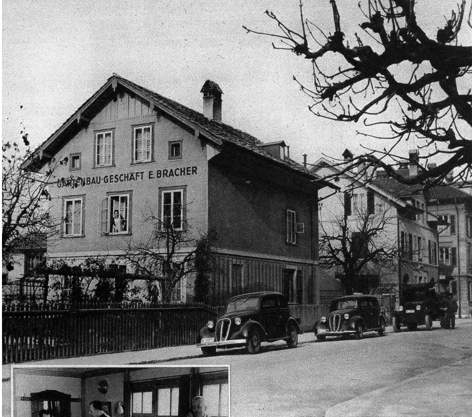
Ansicht des Geschäftshauses
