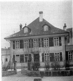
Der ehemalige Herrschaftssitz des Lorrainegutes. Heute hat die Krippe des Lorrainequartiers darin Unterkunft gefunden
