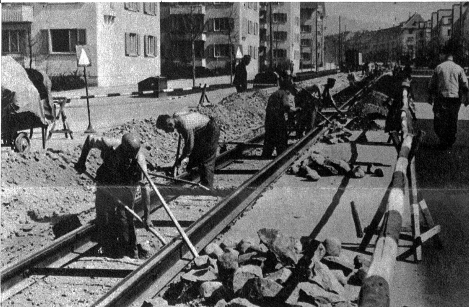
Zwischen den neuangelegten Schienen werden die Löcher für Betonquerswellen gegraben
