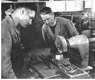
Die besondere Produktion beansprucht Spezialstanzen, welche in eigener Werkstatt hergestellt werden
