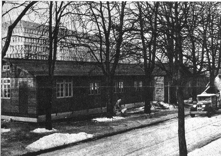
Mitten in Zürich, bei der Sihlpost, ist innert wenigen Tagen eine Barackenbaute entstanden, welche dem Schweiz. Roten Kreuz, Kinderhilfe, sowohl als Administrations- und Verwaltungsgebäude, wie auch als erstes Auffangquartier dient
