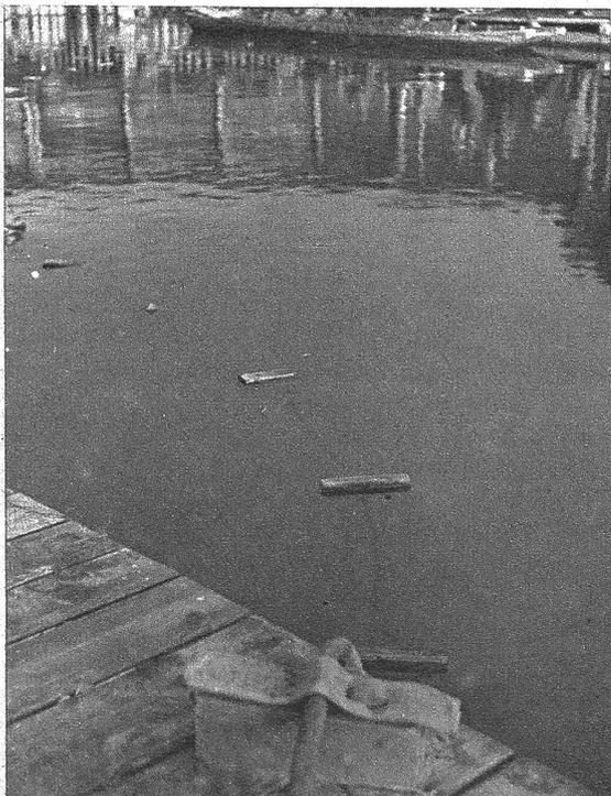
Damit nit eine 3 Wuche muess im Wasser stah und d'Leitig i dr Hand häbe, hei si das Kabel vom Bagger a Holzplöckli verankeret, grad wie dr Fischer syner Netz
