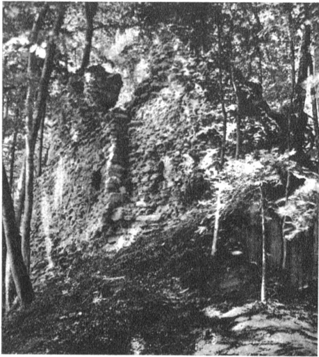
Schloss Grünenberg; Mauerruinen von Süden gesehen
