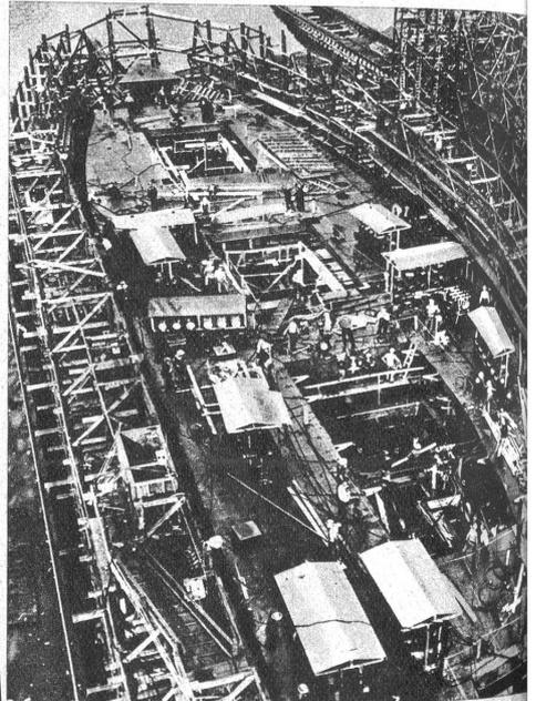
5. Tag. Nach der Kiellegung bringen Tausende von Arbeitern bereits fertige Schiffsteile an Ort und Stelle, so dass man das Schiff buchstäblich wachsen sieht
