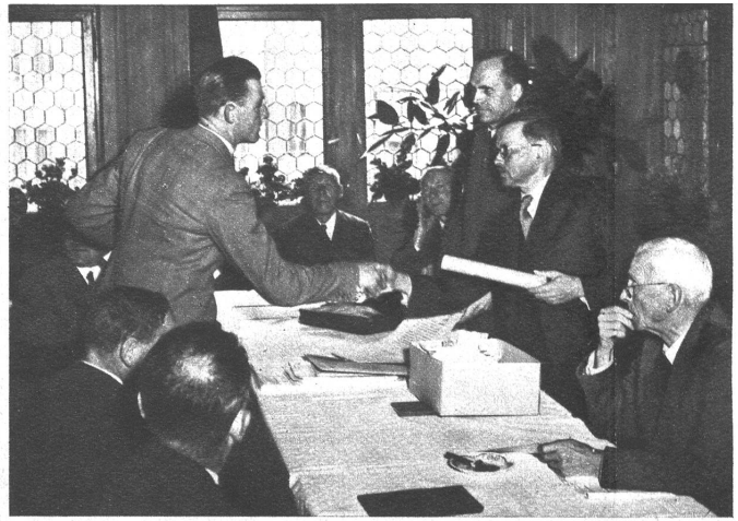
Oben links: „Hochschul-Runkelrüben“ in Zürich. Auf dem Areal der neuen Kantons- und Hochschulturnhalle in Zürich wurden dieser Tage die Runkeln eingebracht. Hinten das Zürcher Hochschulgebäude. — Oben rechts: Die ersten Diplomprüfungen für Gärtnermeister wurden dieses Jahr vom Schweiz. Gärtnermeisterverband durchgeführt. Verbandspräsident E. Haas überreicht einem Kandidaten das Diplom. Links (stehend) neben dem Präs. der Sekretär des Verbandes, Moll, rechts (sitzend) Dr. Böschenstein, Bern, Sekr. des Bundes für Berufsbildung.
