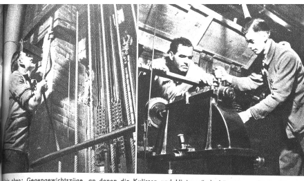
Oben: Gegengewichtszüge, an denen die Kulissen und Hintergründe hängen. — Oben: Die Bühnenmaschinerie sorgt für den Aufzug der Kulissen und Dekorationen auf die Bühne. — Rechts: Die Bühnenmaschinerie für den versenkbaren Teil der Bühne, sogenannte Kassettenversenkung (hier: Leseprobe mit Doswald als Regisseur, Lohner und dem Insizienten Bernhard)
