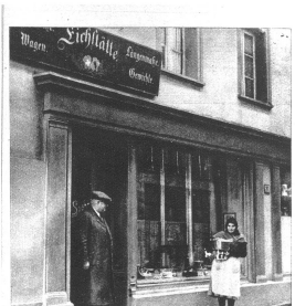
Die Berner Eichstätte. Marktfrauen bringen regelmässig nach Marktschluss ihre Waagen zur Eichstätte zur Kontrolle und Einlagerung bis zum nächsten Markttag. Rechts: Ein neuer Gewichtes „Bett“ wird bis zum annähernden Soll-Gewicht mit Blei ausgegossen. Die genaue Ausregulierung erfolgt auf der Prüfwaage.
