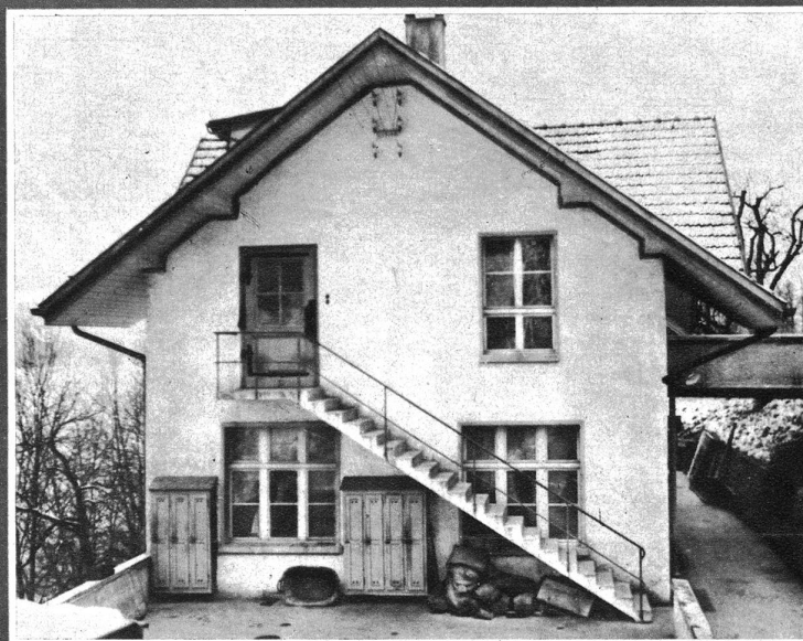
Die Pulverpresshütte nach der Explosion. Ausser den herausgedrückten Fensterscheiben ist nichts von Schäden zu bemerken. Auch der Arbeitsraum ist völlig intakt geblieben
