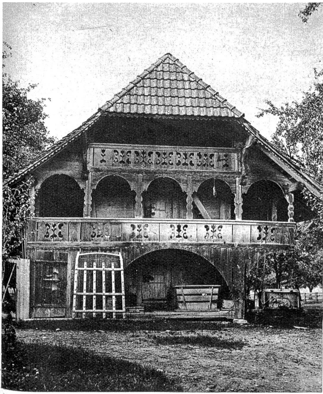
Speicher Lüthi. In der Bauweise der 2. Hälfte des 18. Jahrhunderts. Man beachte die schwungvoll geschnitzten Laubnpfosten mit den formschönen Laubenbögen.
