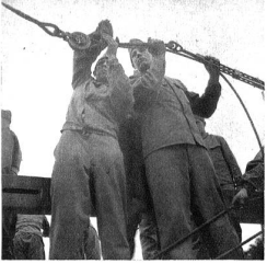
Ein Drahtseil zur weitem Verstärkung der Pontonsbrücke wird gespannt.
