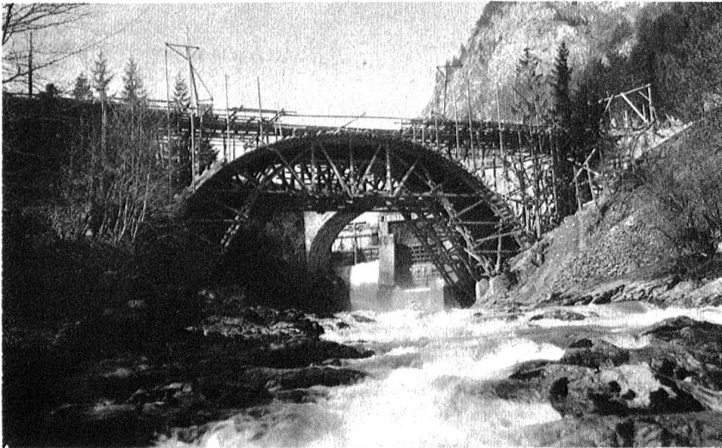
Die neue Simmenbrücke. In Port bei Wimmis wird gegenwärtig eine neue Brücke gebaut. Die Photo zeigt das Leegerüst. Daneben steht die alte Brücke mit der Jahrzahl 1766 und im Hintergrund das Simmenstauwehr.
