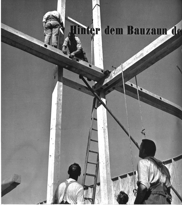
Zimmerleute aus Ostermündigen beim Aufrichten der Stützbalken.
