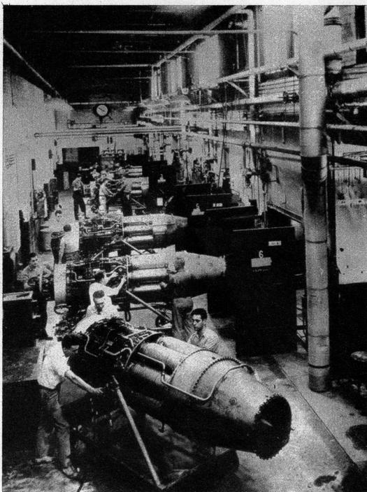
Der Düsenmotor spielt in der amerikanischen Militäraviatik eine immer grösser werdende Rolle. Der einstweilen gebräuchlichste Typ ist der TG-180, der wie ein Torpedo aussieht und bei 2-, 4-, 6- und 8motorigen Kampf- und Bombenflugzeugen Verwendung findet. Hier werden solche Motoren in die Versuchskammern der General Electric's Aircraft Gas Turbine-Fabrik (Neuyork) gebracht, bevor sie nach den verschiedenen Flugzeugfabriken des Landes versandt werden.
