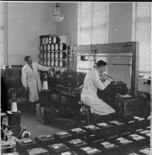
Prüfung eines reparierten Stromwandlers
