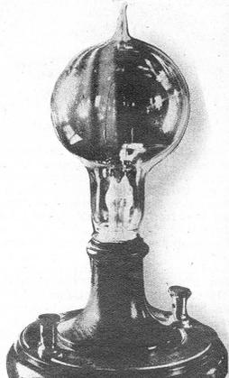
als 16 000 Versuche hatte er mit den verschiedenen Stoffen durchgeführt und die Experimente hatten ihn 40 000 Dollar gekostet. Er stand vor der völligen Entmutigung, als das Experiment endlich gelang. Er karbonisierte einen Baumwoll-Nähfaden, der in eine luftdichte Glasbirne versetzt, vierzig Stunden lang brannte. Allmählich baute er seine Erfindung aus, bis sie kommerziell verwendbar wurde.
