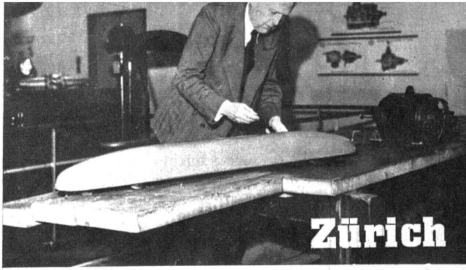
Prof. Kurt Wiesinger mit einem Modell 1 : 20 für elektrischen Antrieb, mit dem, auf die Grossausführung umgerechnet, mehr als 500 Stundenkilometer erreicht worden sind
