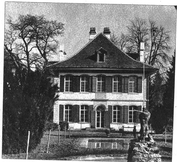
Schloss Oberried in Belp Fassadenrenovation und Umbau
