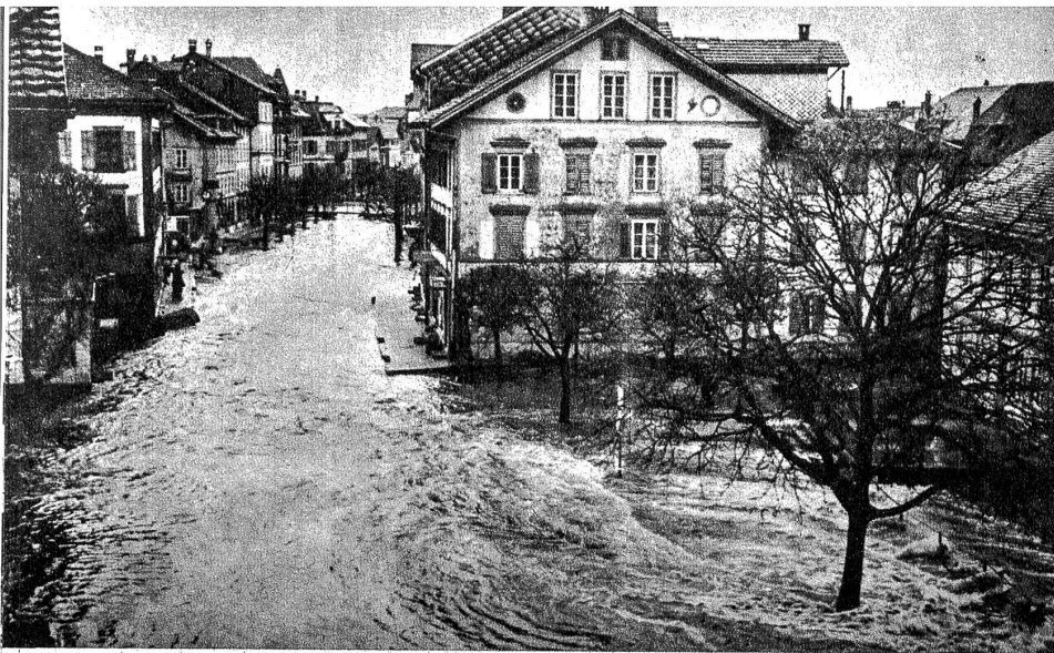
Ungestüm tritt der Bach hier aus seinem gewohnten Bett und überschwemmt die Strassen Langenthals
