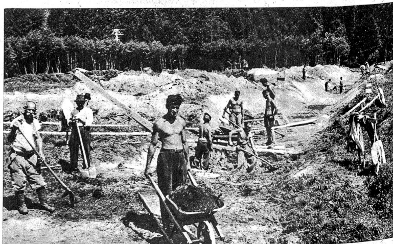
Leute aus dem Arbeitslager halfen bei der Rodung mit Links: Entsumpfungskanäle leiten das überflüssige Wasser in die Aare
