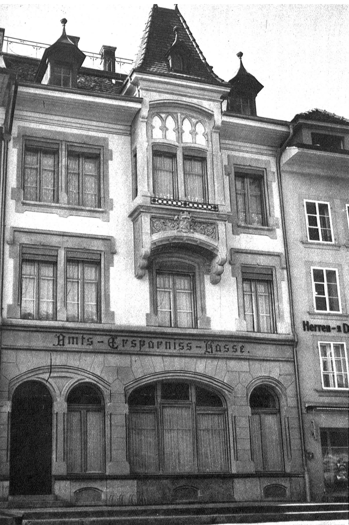
Des Gebäudes der Amtersparnkasse in Aarberg
