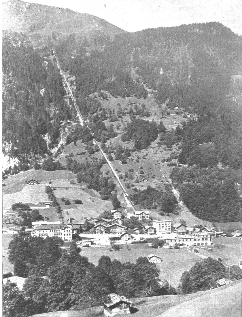
Teilstück Lauterbrunnen-Grütschalp (Photo F. Rohr).
