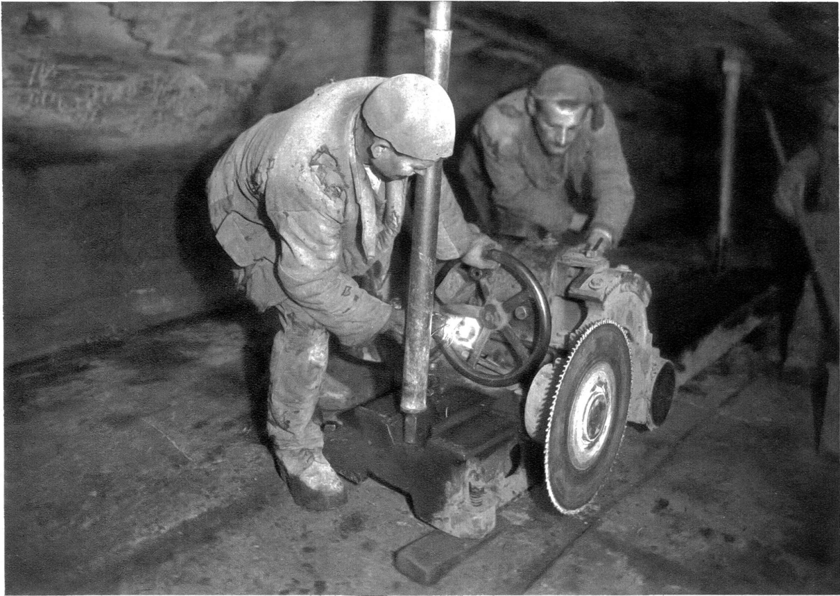
Die Fräsmaschine im Stollen
