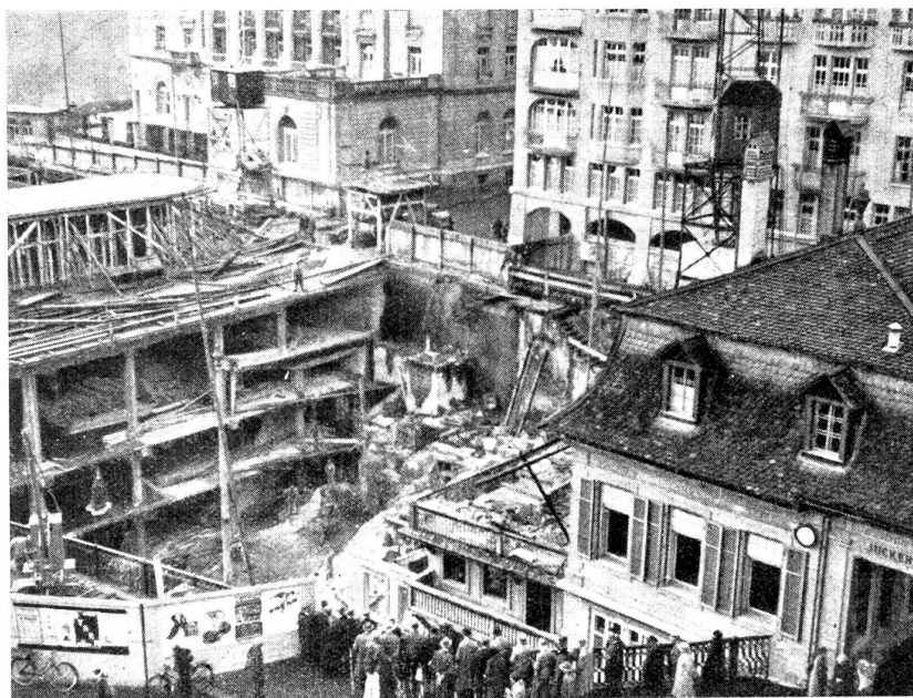
Die interessante Baustelle beim Kasinoplatz in Bern.
