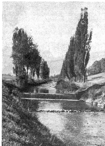
Der Gürbekanal oberhalb Pfandersmatt.
