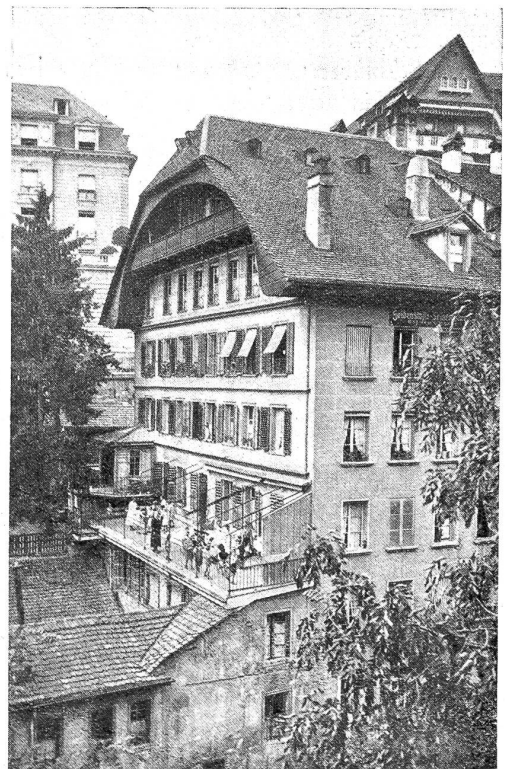
Das aarseits gelegene Haus des Münzgrabens barg eine Kinderkrippe 16
