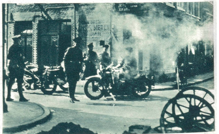
Die schweren Unruhen in Amsterdam, die von den Polizeibehörden als die schwersten seit einer grossen Revolte im Jahre 1917 in Holland angesprochen werden, nehmen ihren Fortgang. Nach den bisherigen Meldungen wurden dabei 6 Personen getötet und 50 verwundet. Scherl.
