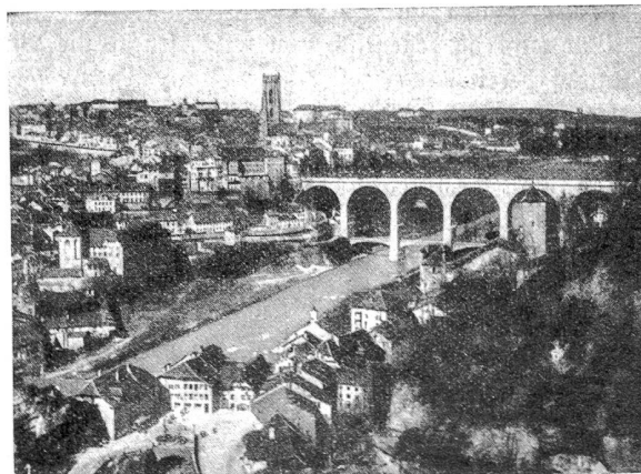
Freiburg. Generalansicht mit Zähringerbrücke.
